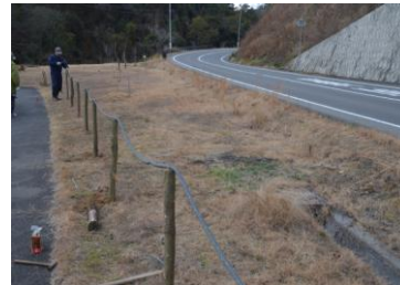
木が腐ったり 車をぶつけて倒壊寸前を整備
