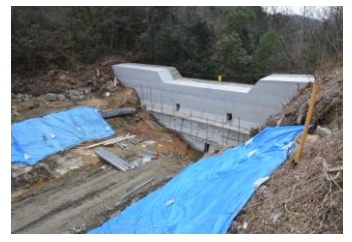
6番砂留上流堰堤修理
