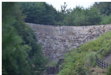
3. 鳶ヶ迫砂留整備
