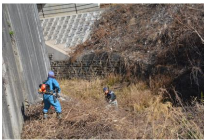
迫山橋北、道路沿いゴミが多い
